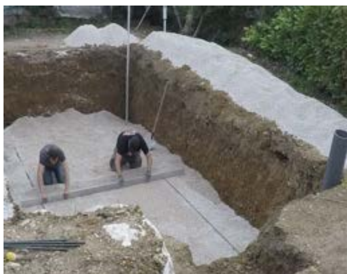
4- Réalisation assise drainante
