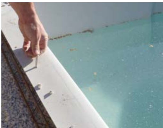
11- Perçage lèvre et raccordement au ferrailage
