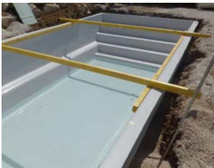
9- Début remblaiement et remplissage
