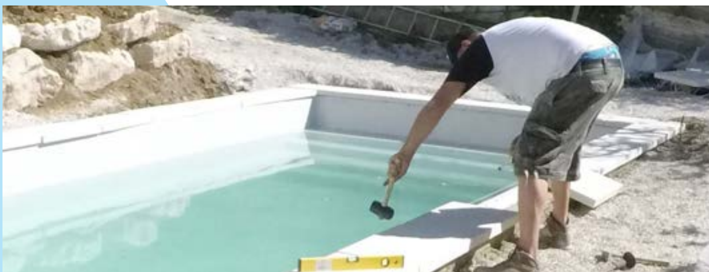
15- Après mise en place des Cordeaux, pose des margelles
