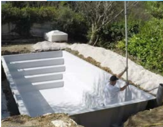
7- Vérification et réglage des niveaux
