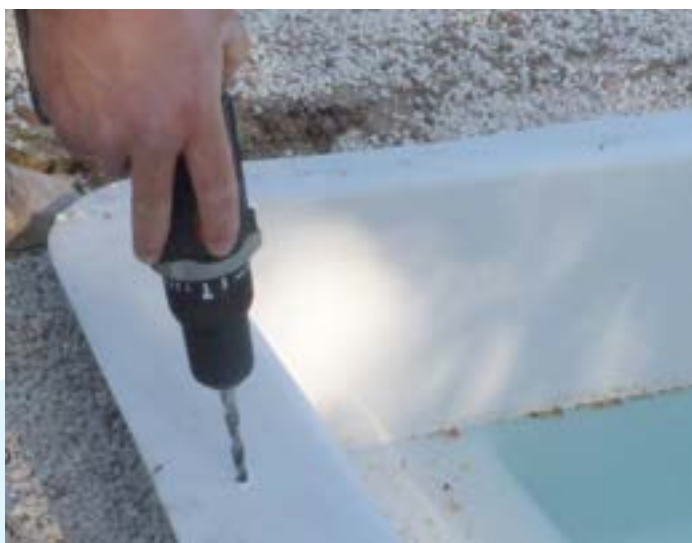
11- Perçage lèvre et raccordement au ferrailage
