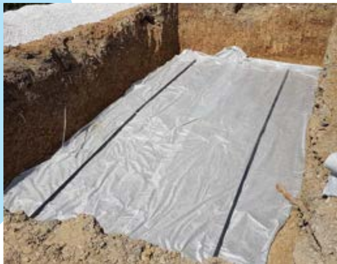
2- Mise en place géotextile
