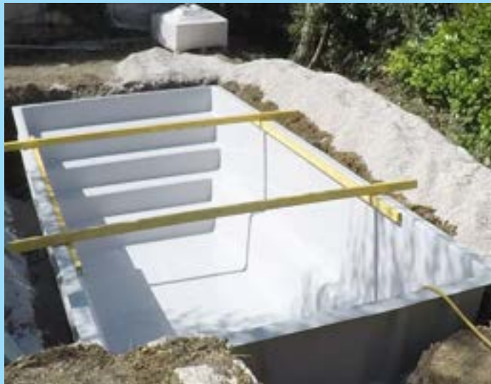
8- Mise en place cadre d'étayage
