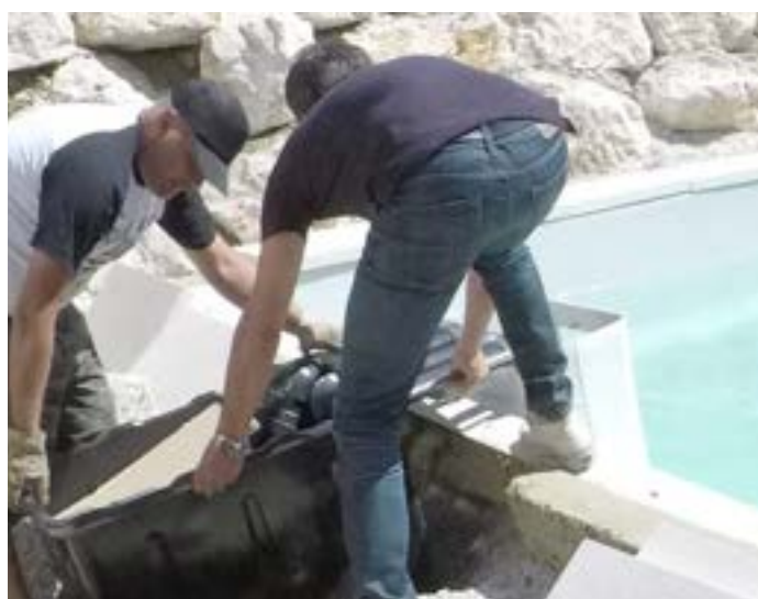
14- Mise en place bloc filtrant
