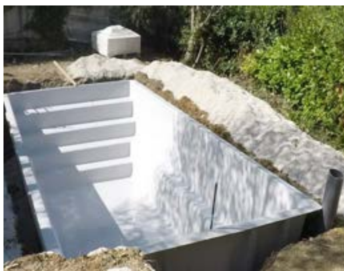
6- Dépose sur assise drainante
