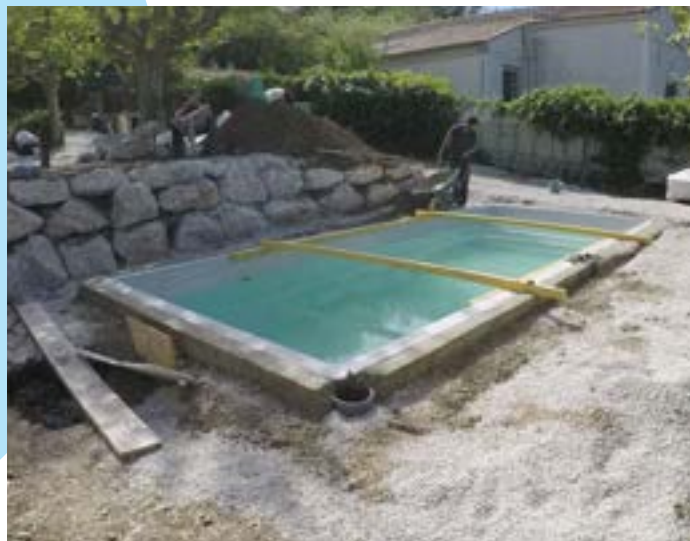
12- Réalisation support éléments de finition en béton
