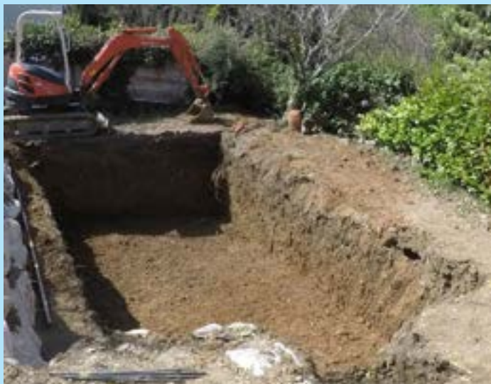
1- Terrassement et fond de fouille propre
