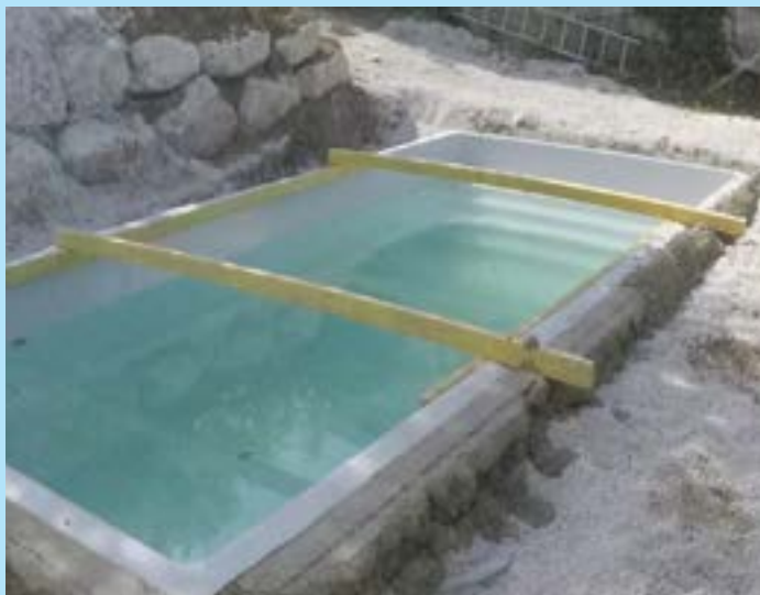
12- Réalisation support éléments de finition en béton
